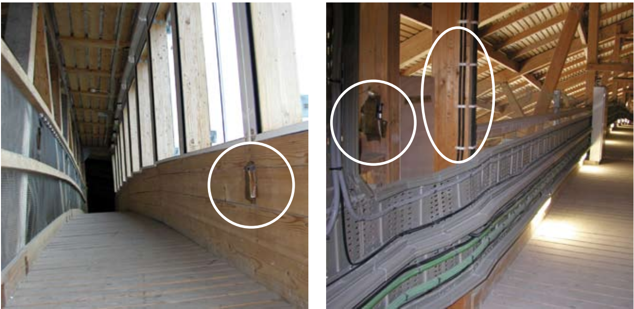
Figura 6 Registadores e agulhas colocados nos passadiços ao nível da cobertura
