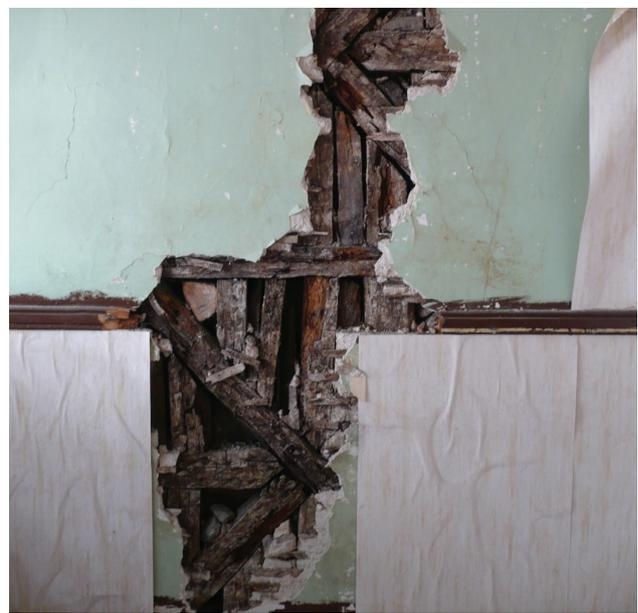
Figura 1 Paredes de tabique: exterior (Penajoia, Lamego [1]) e interior (Porto)
