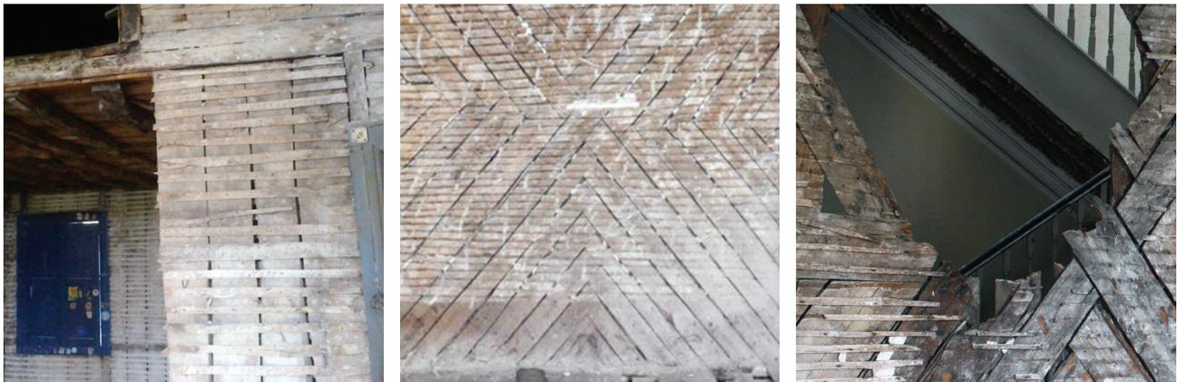
**Figura 2** Parede de tabique simples e tabique duplo (sem o fasquio e pormenor de uma zona em rotura onde se percebe a existência do duplo tabuado)
