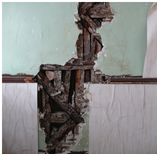
Figura 1 Paredes de tabique: exterior (Penajoia, Lamego [1]) e interior (Porto)
