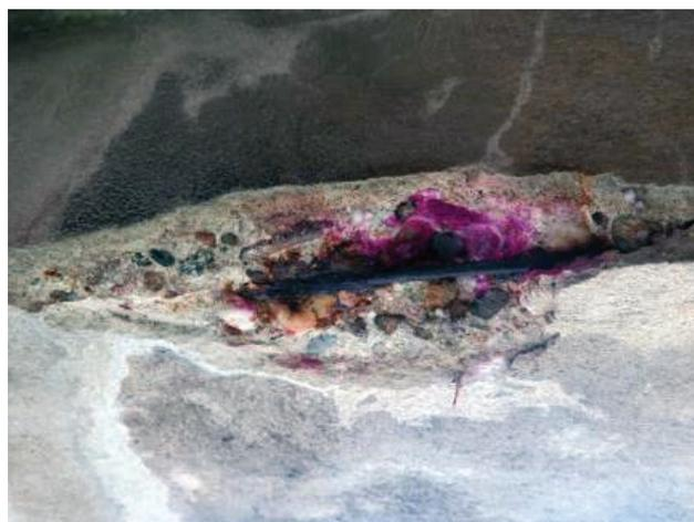
Figura 12 Verificação da profundidade de carbonatação numa zona da viga de bordo com armadura à vista
