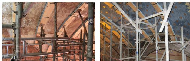
Figura 2 Estado interior del apeado existente en la Iglesia
