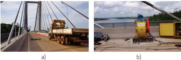
Figura 3 Detalhes do ensaio dinâmico a) Caminhões utilizados para a excitação da ponte; b) Posições do Vibrodina
