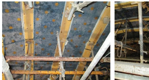
**Figura 10** Puntales empleados como soporte de los sensores
