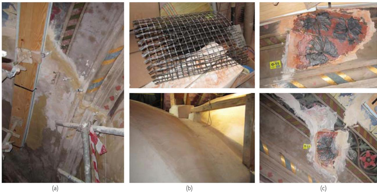
Figura 4 Intervención realizada en el abovedado de ladrillo: (a) Inyección de grietas, (b) refuerzo con malla de fibra de vidrio por la cara superior y (c) realización de anclajes mediante fibras de carbono (fiocos)
