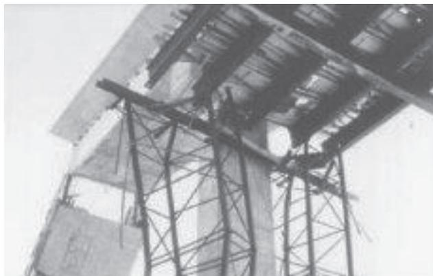
**Figura 2** Colapso da estrutura de escoramento de uma ponte, nos EUA, Ratay [3]
