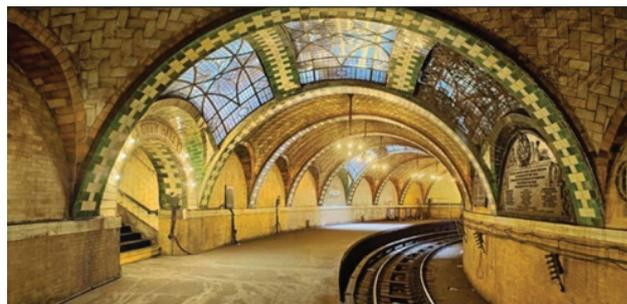
**Figura 6** Exemplos da atividade de Guastavino nos EUA: a) Abóbada fina de tijolo da estação de metro de City Hall, Nova Iorque, 1904 [39]; b) Patente de abóbada de apoio de escada, 1886 [40]
