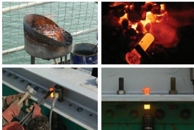
Figura 12 Sequência da cravação de rebite nos trabalhos de reabilitação da ponte sobre o Rio Lima
