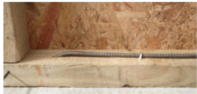
b) Anclaje de barra de acero estriado
