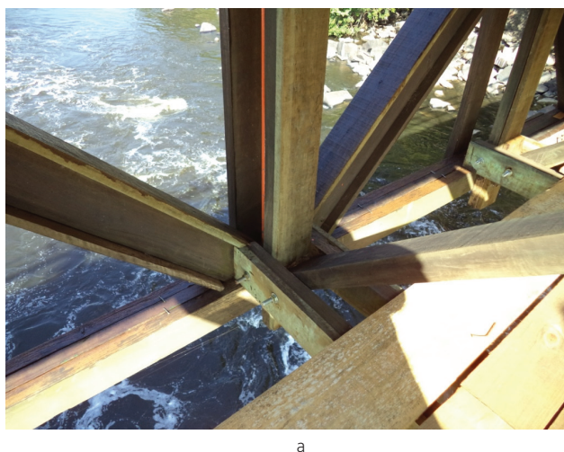
Figura 14 Técnicas de reabilitação de elementos estruturais de Eucalyptus citriodora da Passarela Pênsil de Piracicaba para os casos com biodeteriorações menos intensas em peças de montantes (M), vigas transversinas inferiores (TI), Banzo Inferior (BI), Banzo Superior (BS) foi utilizada a técnica de reabilitação com fixação de cobrejuntas justapostas, com peças novas de 3 cm x 16 cm, de Eucalyptus citriodora tratado com CCA (Fonte: Dussarrat Brito, 2014)
