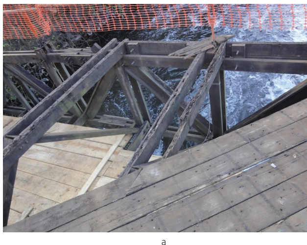
Figura 15 Técnicas de reabilitação de elementos estruturais de Eucalyptus citriodora da Passarela Pênsil de Piracicaba para os casos severos, com alto nível de biodeterioração em peças de vigas transversinas superiores (TS), diagonais de contraventamento (C) e montantes (M): optou-se pela técnica de substituição por peças novas de 6 cm x 16 cm, de Eucalyptus citriodora tratado com CCA, com propriedades físicas semelhantes a recomendadas no projeto estrutural, a fim de preservar as características originais na intervenção (Fonte: Dussarrat Brito, 2014)
