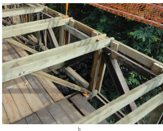
Figura 15 Técnicas de reabilitação de elementos estruturais de Eucalyptus citriodora da Passarela Pênsil de Piracicaba para os casos severos, com alto nível de biodeterioração em peças de vigas transversinas superiores (TS), diagonais de contraventamento (C) e montantes (M): optou-se pela técnica de substituição por peças novas de 6 cm x 16 cm, de Eucalyptus citriodora tratado com CCA, com propriedades físicas semelhantes a recomendadas no projeto estrutural, a fim de preservar as características originais na intervenção (Fonte: Dussarrat Brito, 2014)
