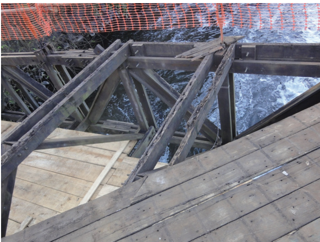
Figura 7 Biodeteriorações com características visuais de fungos apodrecedores, na região superior da seção das vigas transversinas superiores (TS) do módulo m13, em regiões de fixação das tábuas do tabuleiro. Foto: Dussarrat Brito (Inspeção in loco em 09/08/2013)
