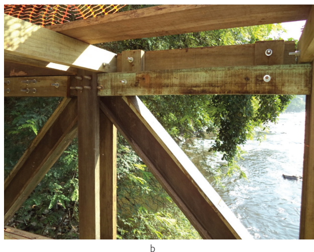
Figura 14 Técnicas de reabilitação de elementos estruturais de Eucalyptus citriodora da Passarela Pênsil de Piracicaba para os casos com biodeteriorações menos intensas em peças de montantes (M), vigas transversinas inferiores (TI), Banzo Inferior (BI), Banzo Superior (BS) foi utilizada a técnica de reabilitação com fixação de cobrejuntas justapostas, com peças novas de 3 cm x 16 cm, de Eucalyptus citriodora tratado com CCA (Fonte: Dussarrat Brito, 2014)
