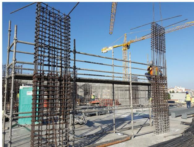
**Figura 13** Pormenorização das armaduras dos pilares – empalmes a meia altura
