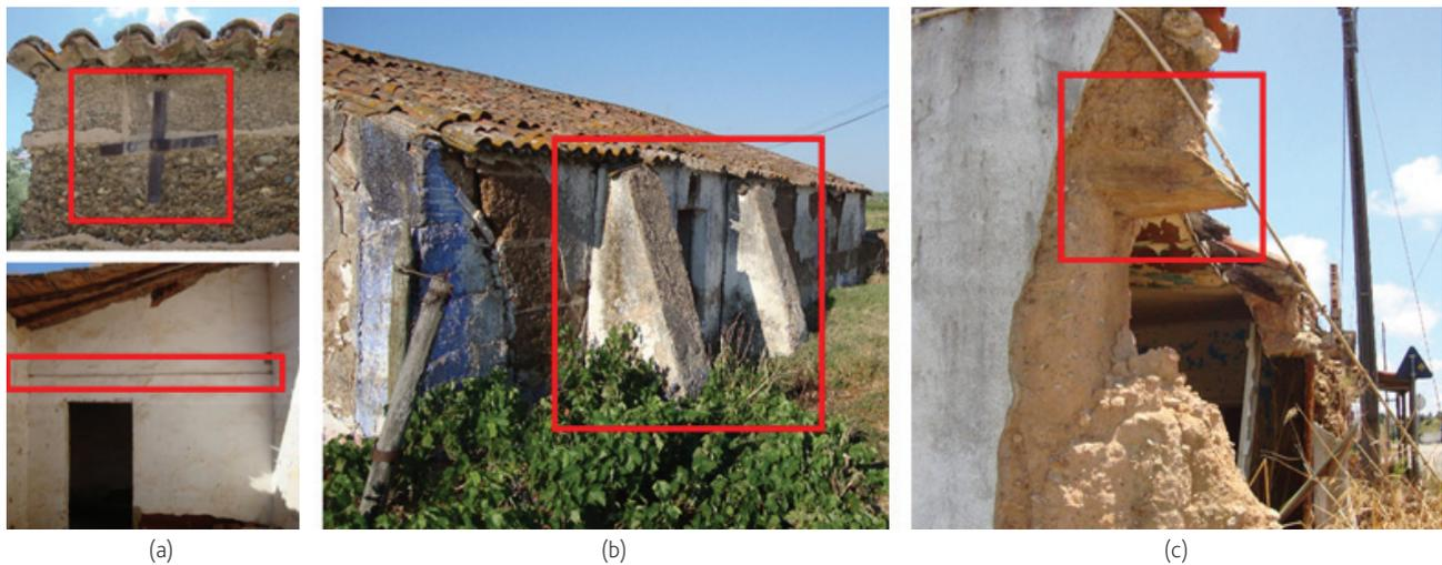
**Figura 2** Técnicas de reforço sísmico utilizadas nas construções tradicionais de taipa do Alentejo: a) tirantes de ferro; b) contrafortes; c) elementos de reforço dos cunhais
