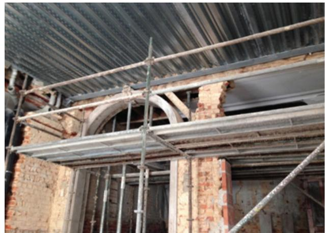
**Figura 6** a) Solução estrutural de reforço no Bloco A para cargas verticais nos pisos elevados; b) Pórticos metálicos e laje mista aço-betão, visíveis durante a fase de construção
