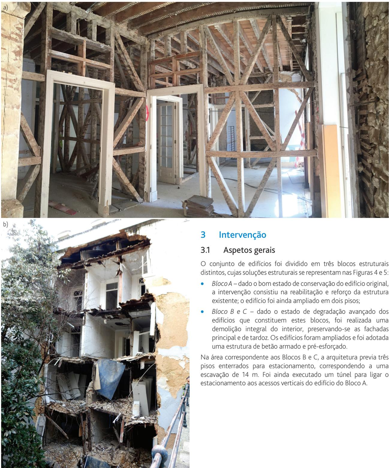
**Figura 3** a) Edifício 1: Paredes interiores (após demolição de enchimento); b) Edifício 2 – Colapso
