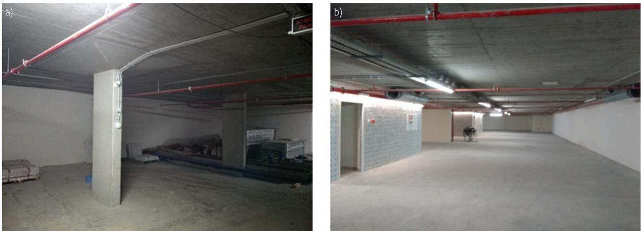
Figura 13 a) Laje maciça com capitéis nos pisos enterrados; b) Laje maciça pós-tensionada, nos pisos enterrados
