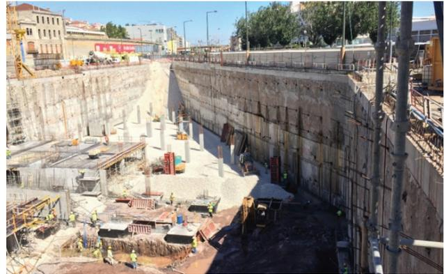
Figura 5 Vista parcial das paredes de contenção
