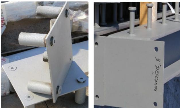
Sockets a inserir nas nervuras pré-esforçadas e viga I
