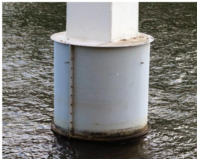
**Figura 10** Solução de encamisamento da base dos pilares no troço submerso
