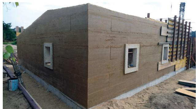
Figura 1 Paredes de uma casa de taipa em construção.
