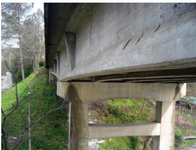
**Figura 3** Esmagamento de aparelho de apoio em chumbo e delaminação do betão na viga do lado norte
