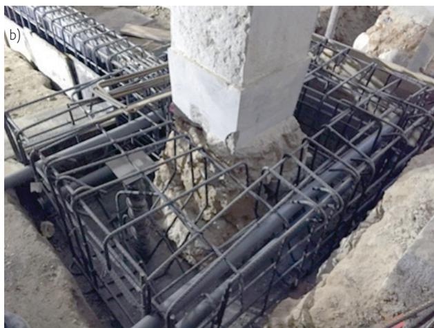
**Figura 8** Reforço de fundações. (a) Esquema do reforço dos pilares de pedra por encamisamento e da fundação; (b) Fotografia durante a fase construtiva de reforço da fundação
