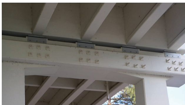
Figura 6 Reforço das carlingas para elevação do tabuleiro e suporte dos novos aparelhos de apoio
