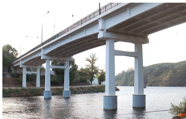
Figura 9 Vista do lado sul – Proteção da zona submersa dos pilares
