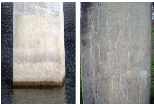
Figura 2 Fendilhação na face do Pilar P2 e P4 devido a reações expansivas álcalis-silica
