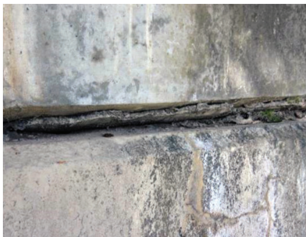
Figura 2 Fendilhação na face do Pilar P2 e P4 devido a reações expansivas álcalis-silica
