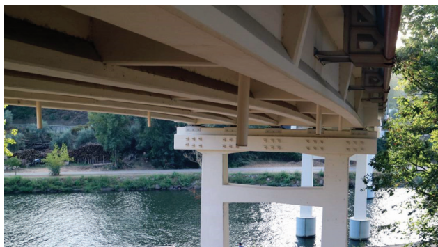
Figura 7 Vista inferior do tabuleiro após os trabalhos de reabilitação
