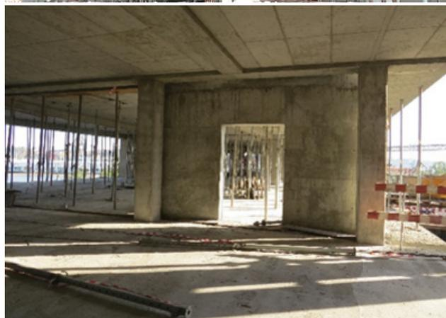
**Figura 12** Pormenorização da viga de acoplamento
