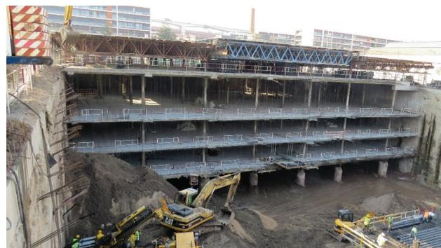
Figura 9 Asnas, tirantes de suspensão e estrutura já realizada na zona do *top/down*
