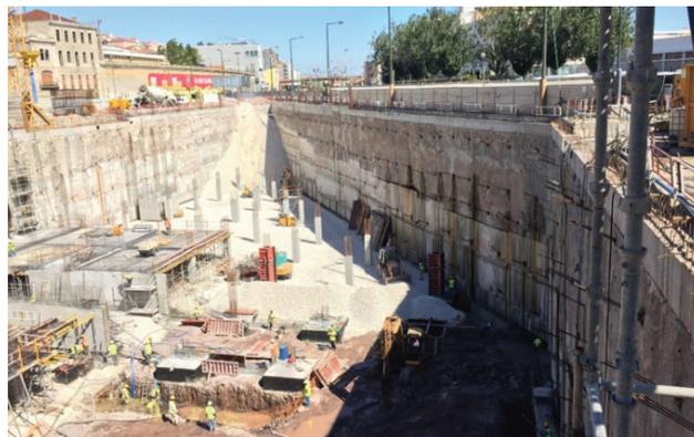
Figura 5 Vista parcial das paredes de contenção
