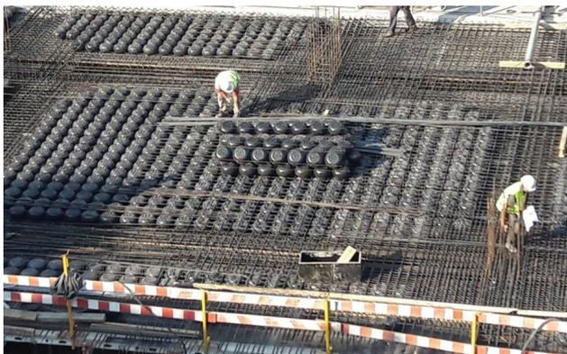
**Figura 15** Laje aligeirada do tipo “Cobiax”
