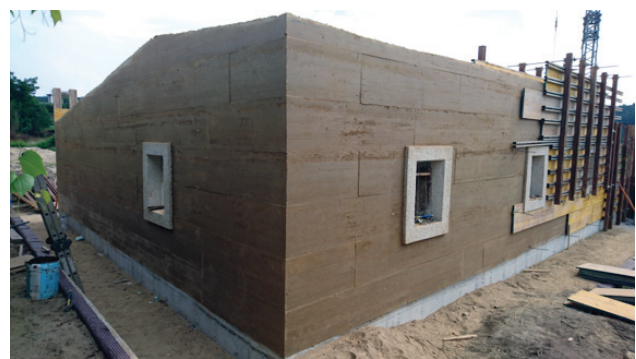
Figura 1 Paredes de uma casa de taipa em construção.
