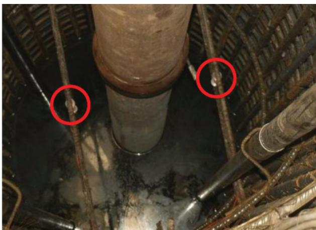
Figura 9 Extensómetros durante a betonagem de estaca
