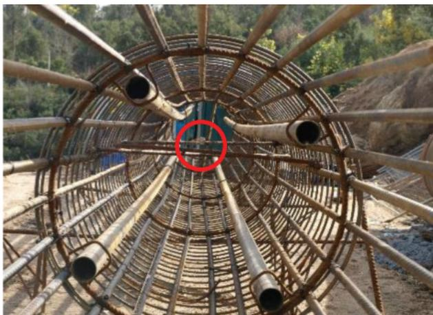
Figura 7 Extensómetro instalado na armadura de uma estaca
