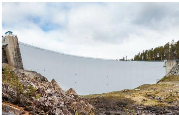
a) Foto da barragem tipo com isolamento colocado
