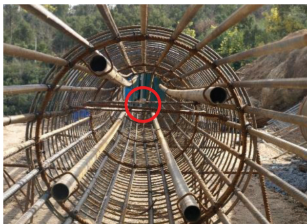
Figura 7 Extensómetro instalado na armadura de uma estaca
