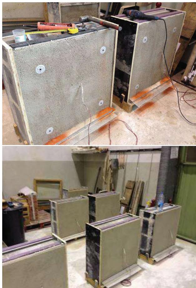
Figura 14 Aplicação dos revestimentos armados nos novos muretes
