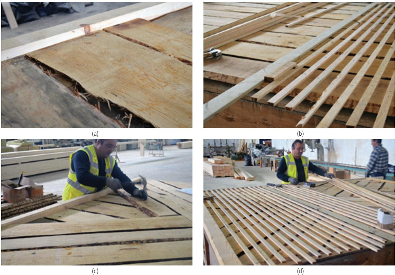
**Figura 2** Construção das paredes de tabique em fábrica: a) PTS ligação das tábuas ao frechal; b) PTS pregagem do fasquio à fileira de tábuas verticais; c) PTD pregagem das tábuas diagonais contra as tábuas verticais; d) PTD pregagem do fasquio (créditos: Andreia Rebelo)
