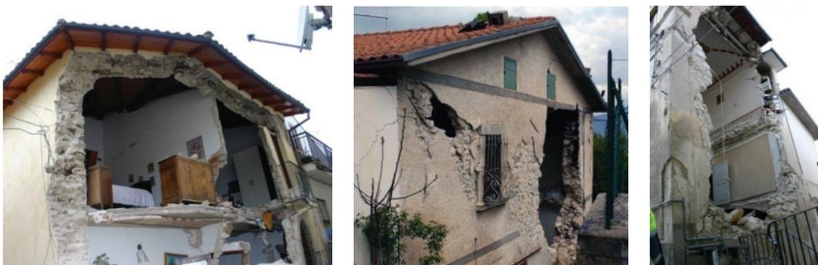
Figura 1 Exemplos de modos de colapso de paredes de alvenaria de pedra em edifícios após o sismo de L'Aquila – 2009 [1]
