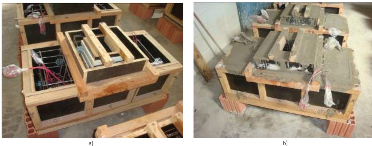
Figura 8 Concretagem dos blocos de fundação (modelo M4)
