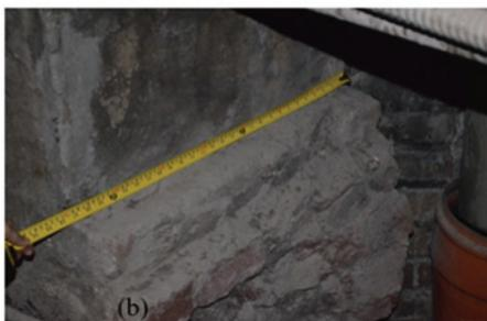
**Figura 15** Parede lateral da cúpula: (a) radargrama; (b) determinação da espessura.
