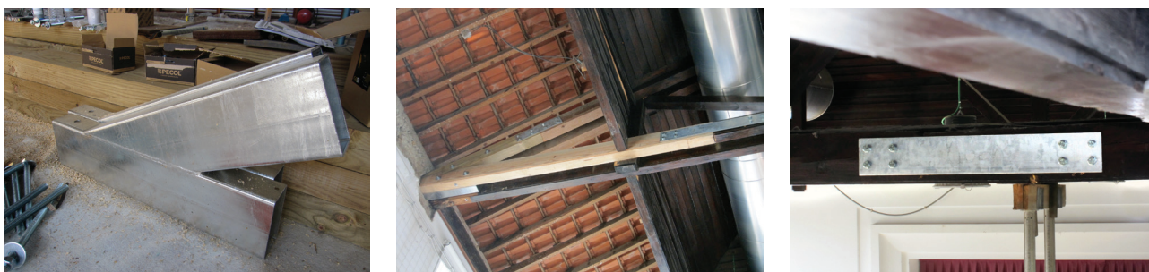
Figura 13 Execução: a) Peças metálicas; b) linha partida; c) raio de Júpiter
