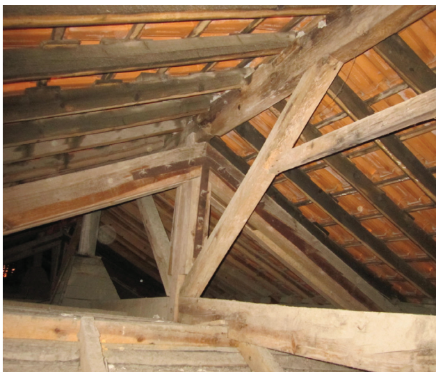
Figura 7 a) Estrutura principal em boas condições; b) Elementos secundários degradados
