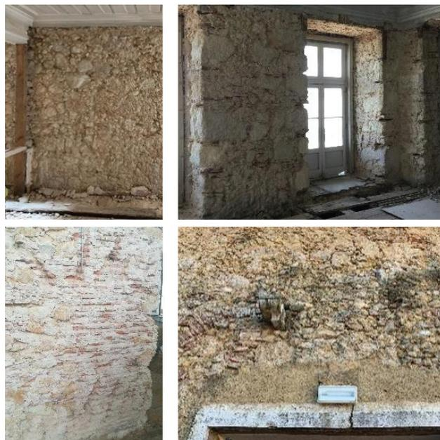
**Figura 1** Exemplos de diferentes tipos de alvenarias antigas de Lisboa, projetos A2P
