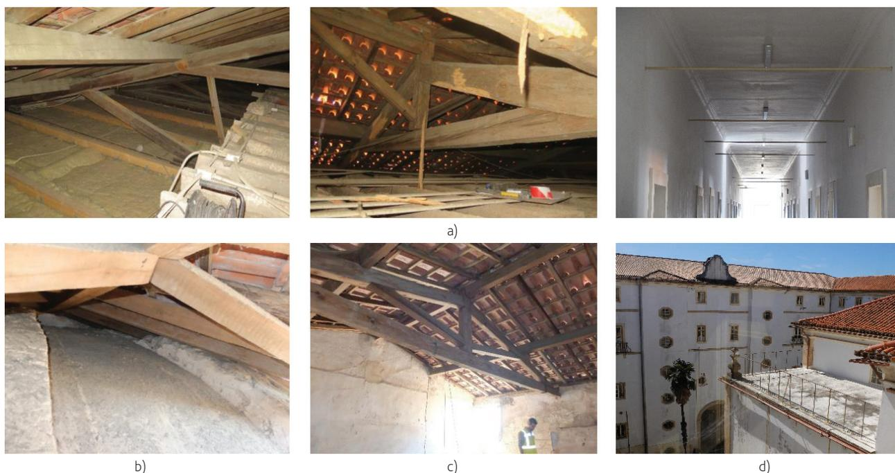
**Figura 7** Coberturas de madeira do edifício central do SMC
