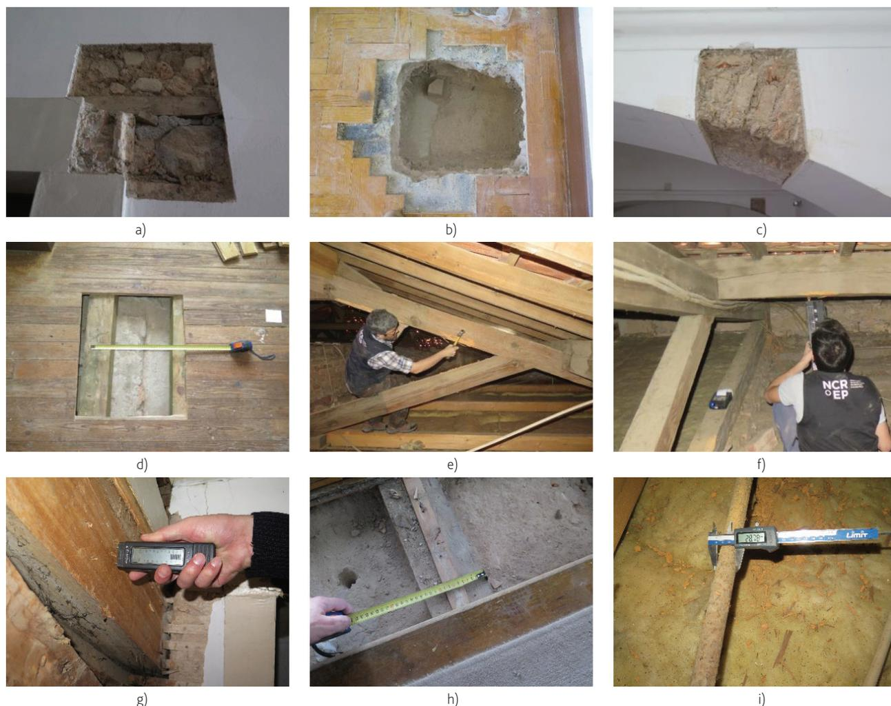
Figura 2 Ações de inspeção e diagnóstico – sondagens e ensaios complementares
