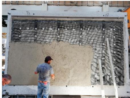
Aplicação da segunda camada de reboco
