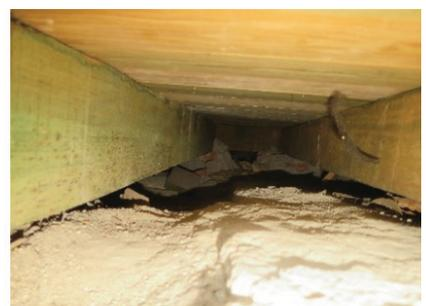
**Figura 6** Estrutura do pavimento de madeira sobre abóbadas
