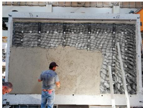
Aplicação da segunda camada de reboco
