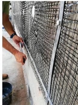
Detalhe da fixação ao pórtico de betão armado
