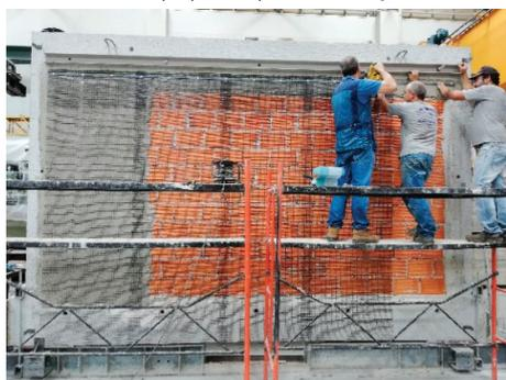
Posicionamento e fixação da rede de armação
