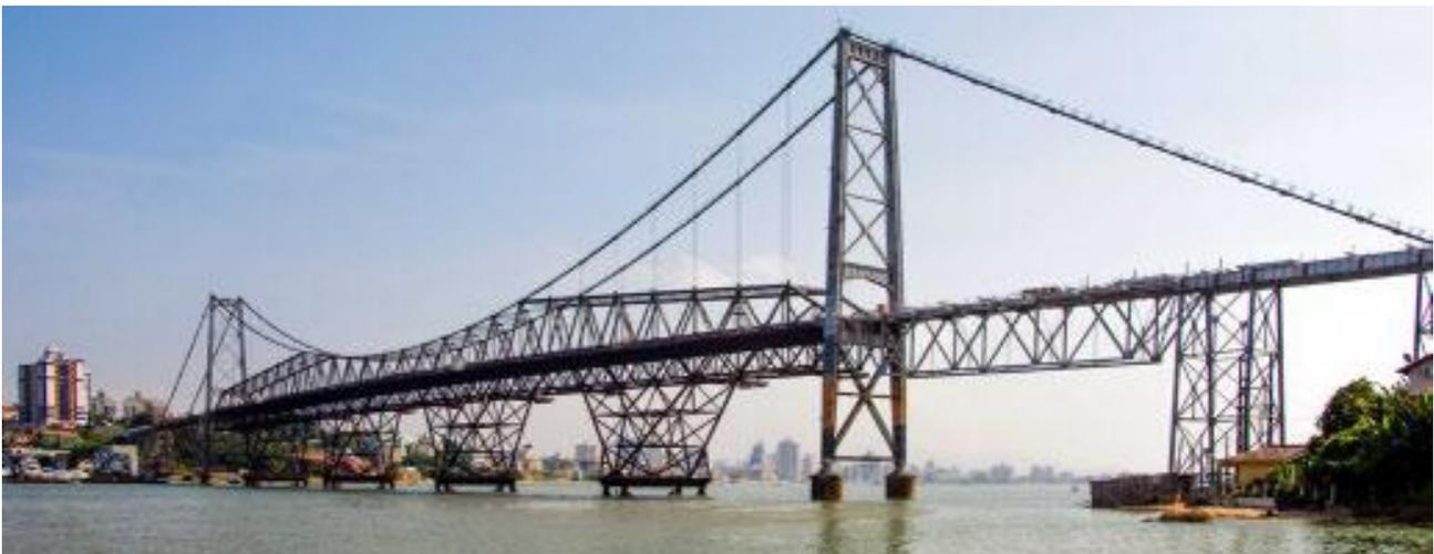
Figura 2 Estrutura de suporte provisória
