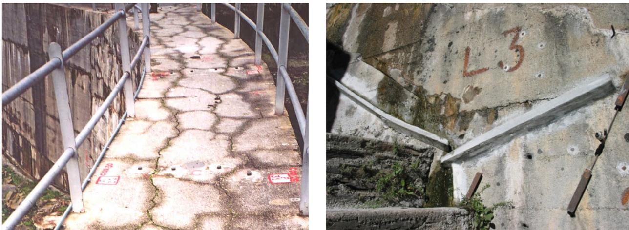
**Figura 3** Barragem do Alto Ceira. Fendilhação difusa, do tipo craquelê, no piso do coroamento (à esquerda) e bica no paramento de jusante para coletar repasses pelas fendas (à direita)
