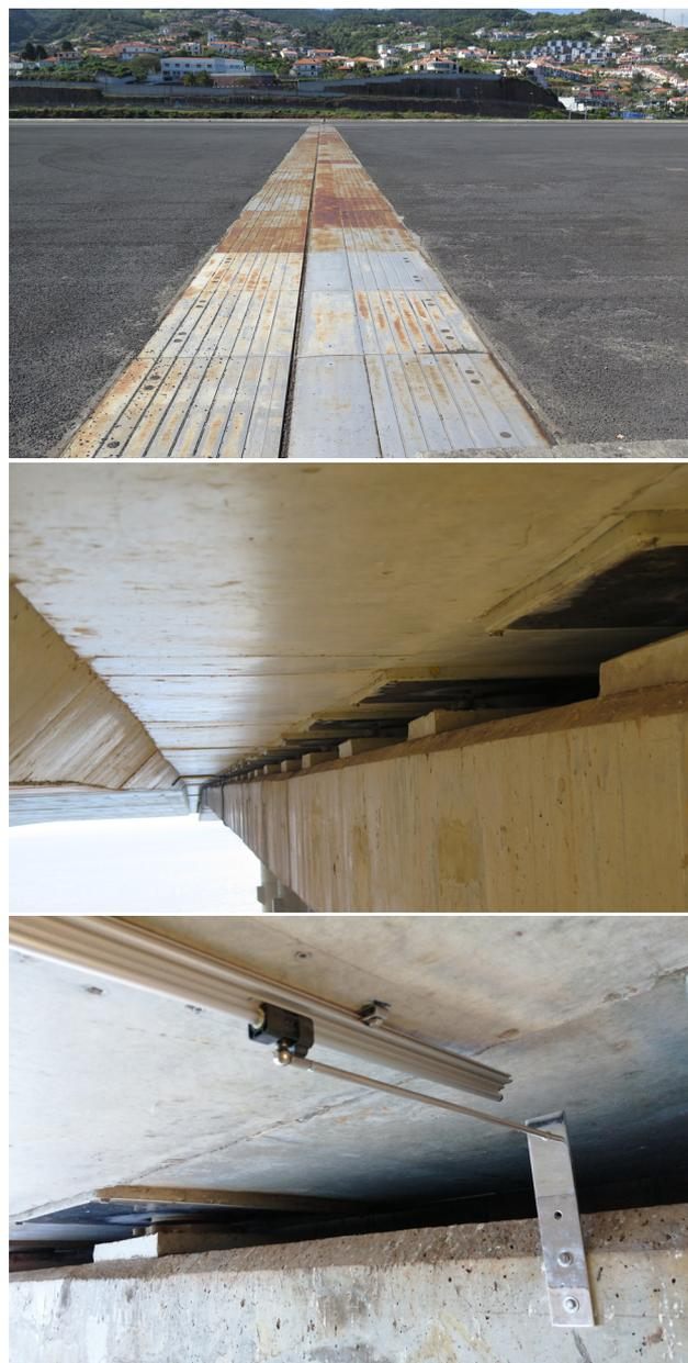
Figura 4 Junta de dilatação principal: vista geral e detalhe da instrumentação
