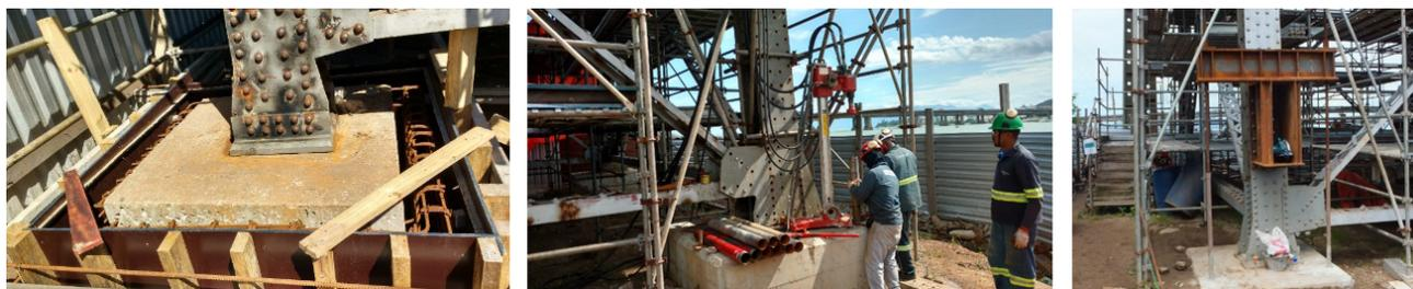
Figura 3 Encamisamento, perfuração e tirantes tensionados
