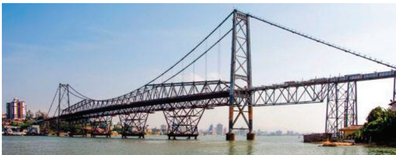
Figura 2 Estrutura de suporte provisória
