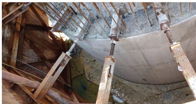
Figura 5 Montagem e colocação em serviço das ensecadeiras em serviço, primeira fase de betonagem e nível de escoramento
