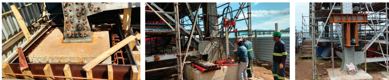
Figura 3 Encamisamento, perfuração e tirantes tensionados
