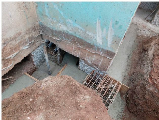
Figura 8 Pormenor da picagem dos pilares e das vigas de fundação existentes
