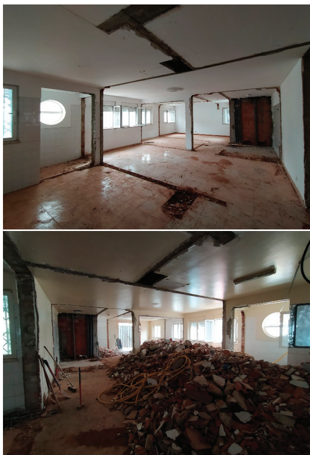
Figura 10 Remoção do interior do R/C do edifício e manutenção das fachadas
