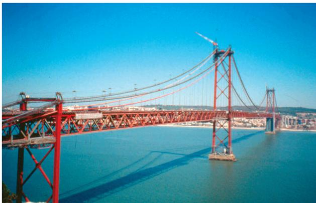
**Figura 10** Ponte 25 de Abril – Solução adoptada (2.º cabo aquando da execução (1998) para o reforço exigido pela instalação ferroviária
