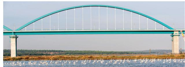
**Figura 23** Tramo extremo sul do “Bowstring” da Ponte sobre o Sado
