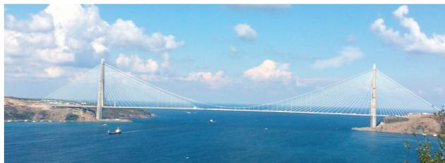
Figura 7 Vista da 3.ª Travessia do Bósforo – Ponte rodoferroviária, suspensa e atirantada (projecto de execução TIng, Greisch, Grid)
