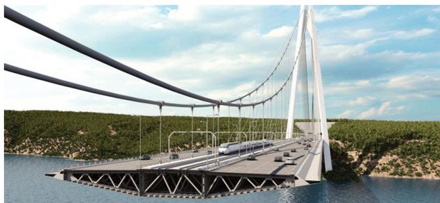
Figura 8 Secção transversal da 3.ª Travessia do Bósforo – Ponte rodoferroviária, suspensa e atirantada (projecto de execução TIng, Greisch, Grid)
