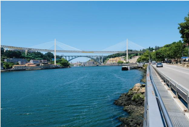
**Figura 20** Estudo de concurso da nova ponte ferroviária para o Metropolitano do Porto, com tabuleiro em curva com  $R = 500$  m e um vão principal  $L = 322,5$  m. Solução de tabuleiro a dois níveis e com dois planos de tirantes
