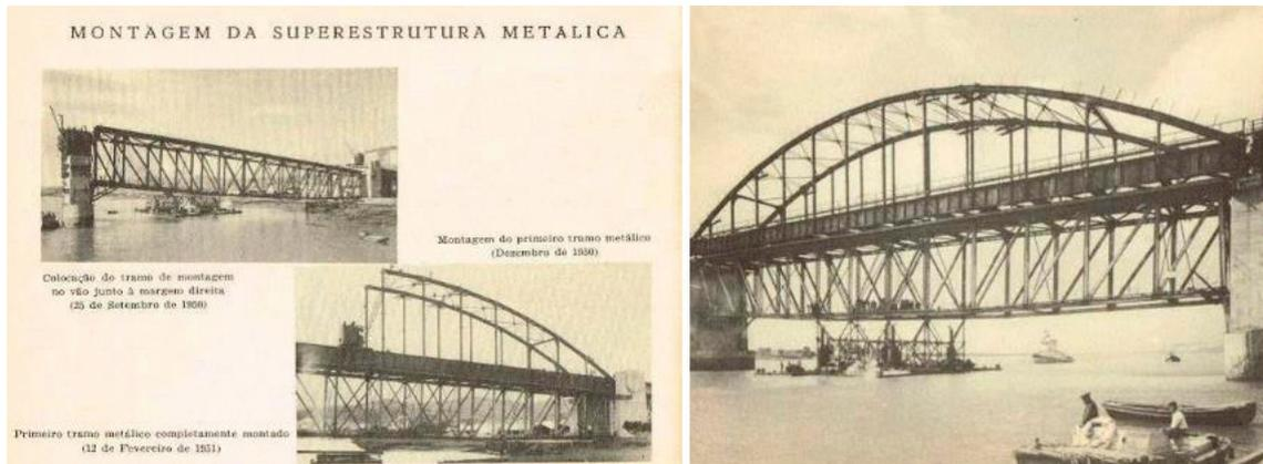
Figura 16 Processo construtivo de montagem do tabuleiro da Ponte de Vila Franca de Xira
