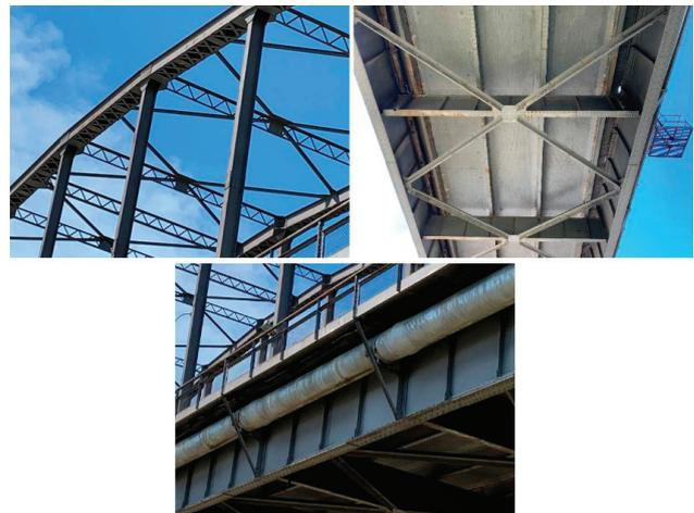
Figura 6 Estrutura da ponte – arcos e tabuleiro
