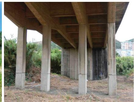
**Figura 11** Pilares intermédios das subestruturas dos viadutos
