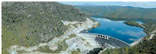
Figura 6 Vista aérea da Barragem do Baixo Sabor, adaptado de [25]
