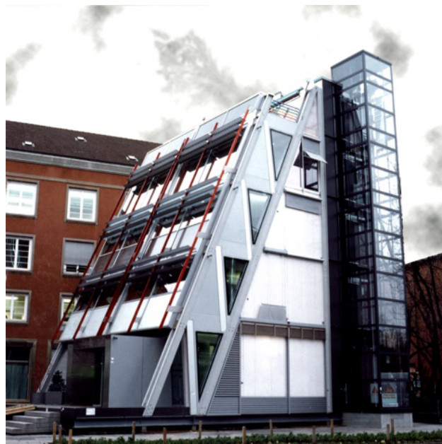
Figura 1 Edifício com estrutura treliçada em perfis pultrudidos de compósito de fibra-polímero (Thomas Keller, EPFL-CCLab)
