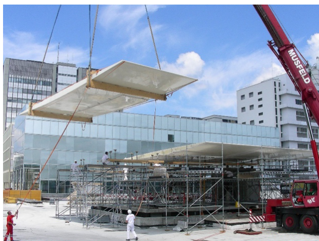
Figura 2 Cobertura em painéis sanduíche com faces e almas em compósito de fibra-polímero e núcleo em espuma de poliuretano (Thomas Keller, EPFL-CCLab)
