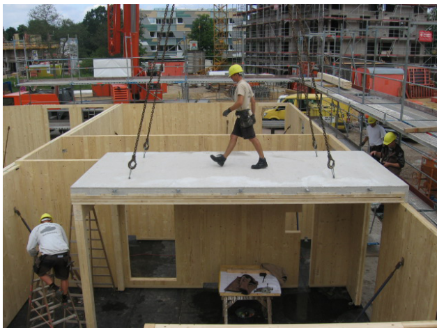
Figura 3 Exemplo de construção com solução mista madeira-betão
