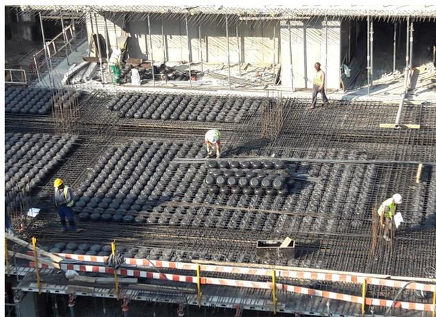
**Figura 7** Lajes aligeiradas e lajes mistas adotadas no edifício
