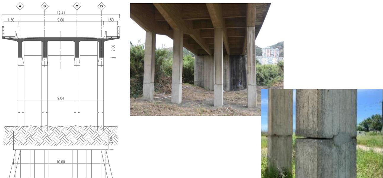
Figura 12 Pilares intermédios das subestruturas dos viadutos com montantes articulados
