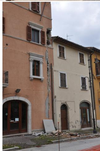
**Figura 1** Danos para fora do plano e no plano em agregados existentes, após o terramoto no centro de Itália de 2016, em Visso (Fotografias: A. Penna e G. Guerrini)
