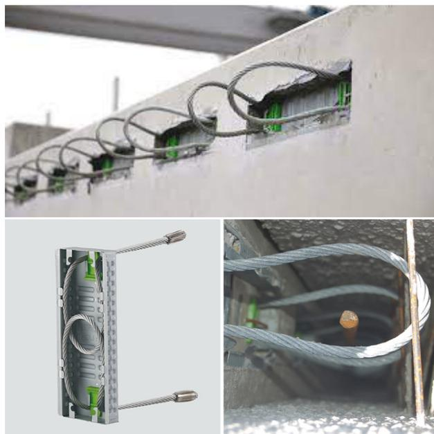
Figura 7 Pfeifer VS Slimbox na interface entre painéis de laje CREE
