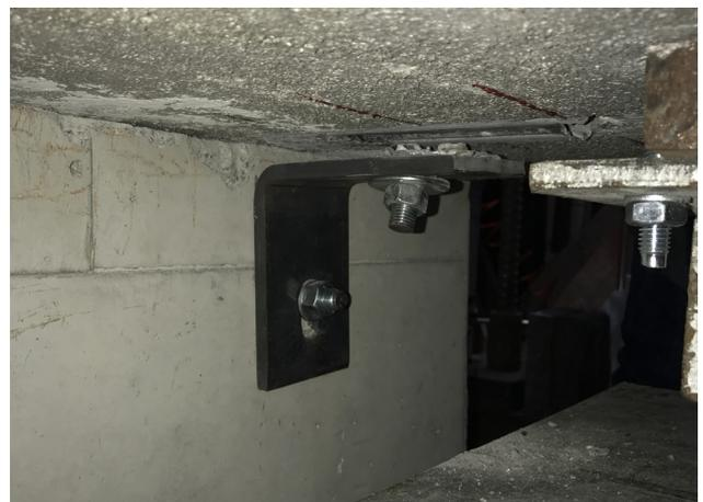
j) Parafuso expulso da calha CPC\_O\_14
