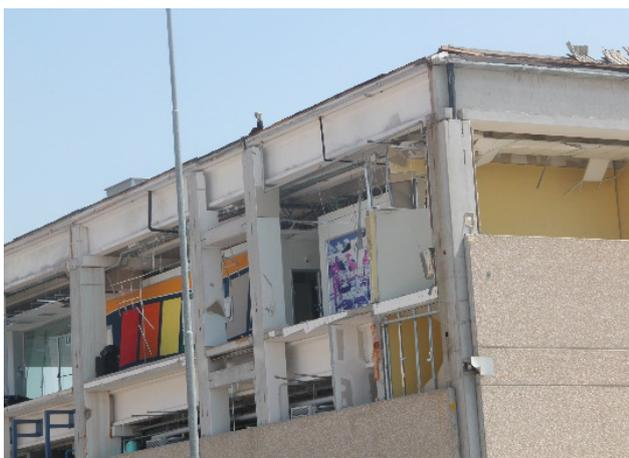
Figura 2 Falha das ligações de painéis horizontais, sismo Emília 2012
