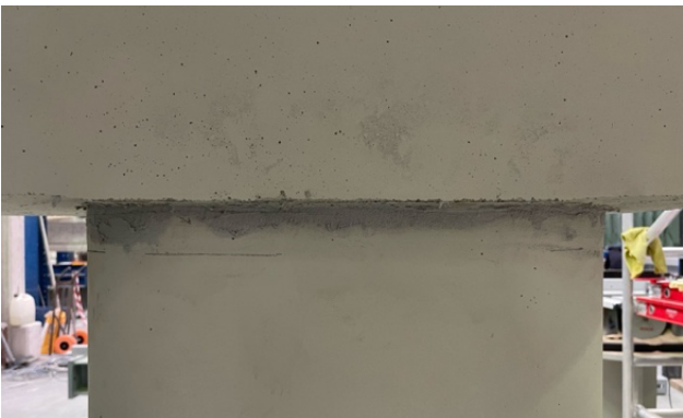
(b) após preenchimento com SikaDur-30
