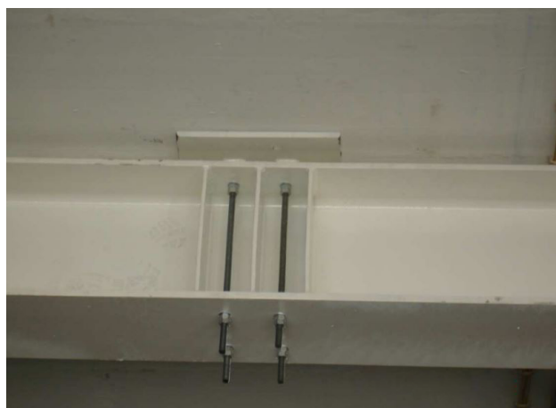
Figura 2 Reforço e Reparação do Edifício dos Bombeiros Voluntários da Trafaria. Vista geral e pormenor do sistema de aplicação do pós-esforço [6]
