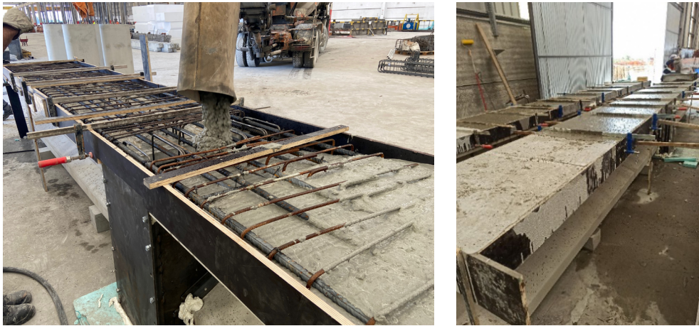
Figura 3 2.ª fase de betonagem (C-F-1) e 3.ª fase de betonagem (C-F-2)
