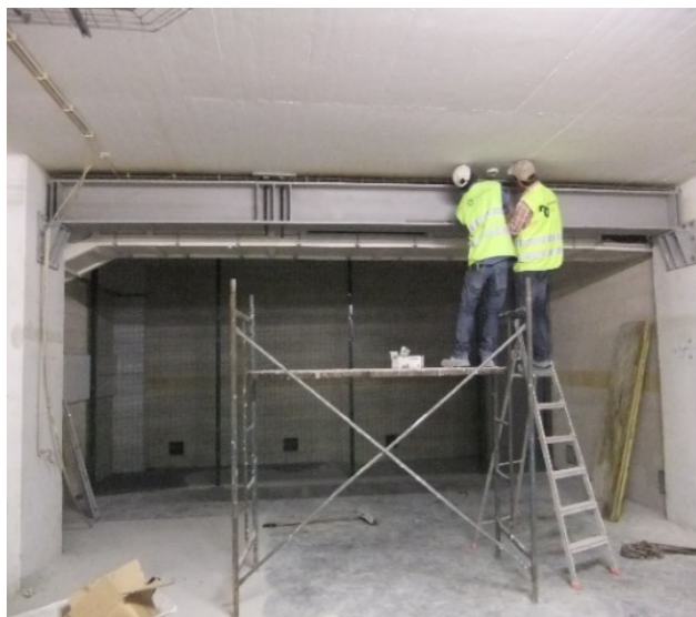
Figura 1 Reforço e Reparação do Edifício Visconde de Alvalade. Alçado da viga metálica e pormenor do sistema de aplicação do pós-esforço [5]
