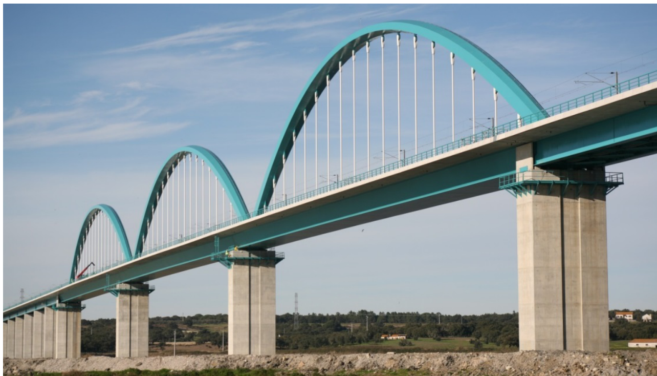
Figura 1 Ponte vista geral de jusante
