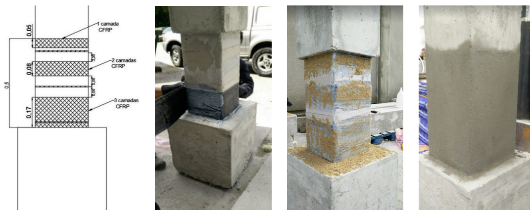
Figura 2 Processo de reparação e reforço com esquema das cintas em metros
