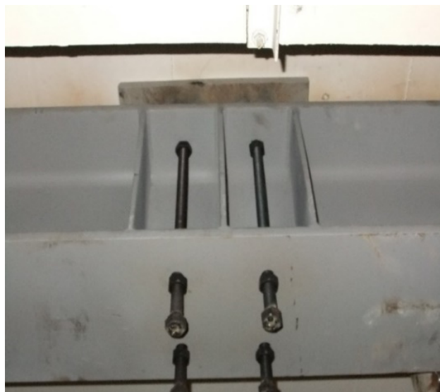
Figura 1 Reforço e Reparação do Edifício Visconde de Alvalade. Alçado da viga metálica e pormenor do sistema de aplicação do pós-esforço [5]
